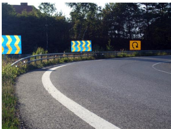
Farlig motorvejsafkørsel, der er forbundet med en del uheld i Ljungarum, Sverige, før autoværnene blev udskiftet i 2012.
