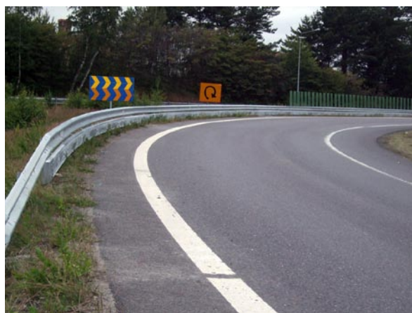
Samme motorvejsafkørsel efter de nye autoværn med motorcykelafdækning er opsat.
